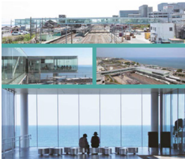
Dans la gare d'Hitachi au Japon, on a pris en compte le vieillissement de la population japonaise dans la nouvelle organisation de la gare. En outre, dans un souci de confort, elle a été conçue pour que l'on y voie la mer et pour que celle-ci se reflète dans les matériaux qui ont servi à construire la gare. (Source : Brunel Awards 2014)
