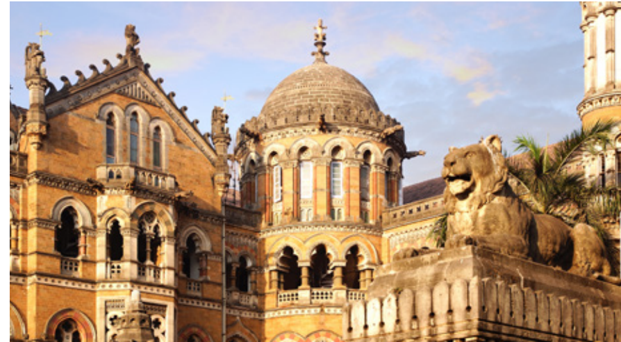
Chhatrapati Shivaji Terminus, construite entre 1878 et 1888 (Source : Fotolia)
