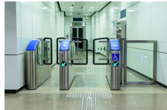
Signalétique au sol et passage adapté aux voyageurs en fauteuil roulant pour un meilleur accès aux quais.
