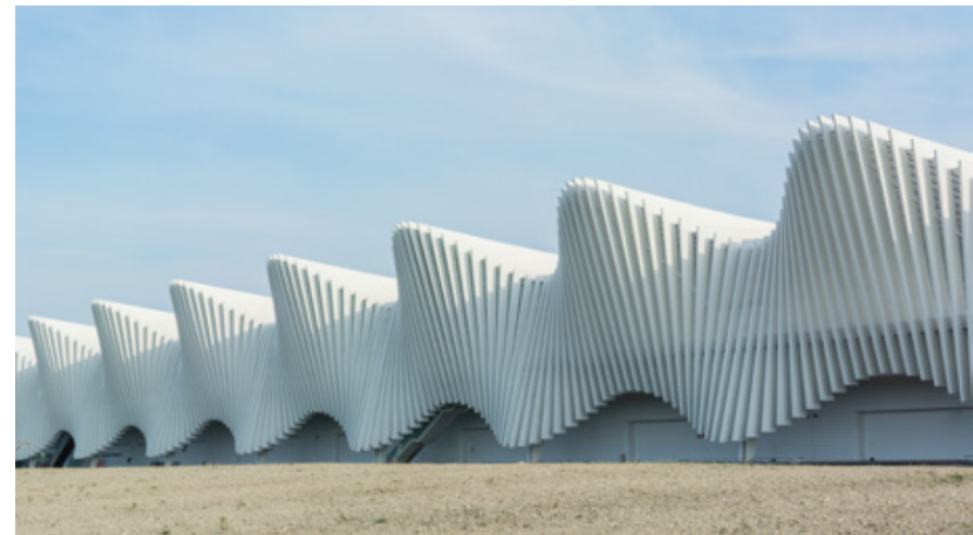
La gare Reggio Emilia, dont le projet a été élaboré par l'architecte Santiago Calatrava, a été inaugurée le 8 juin 2013. Son évolution sinusoidale à vague est assurée par une succession de portiques à section fermée et différents sur le plan géométrique (Source : Fotolia)
